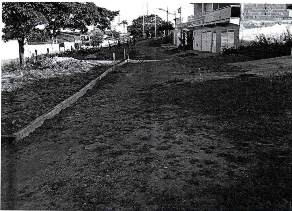
FOTO 3. IMAGEM DO LOCAL COM ARRUAMENTO (MEIO FIO)
